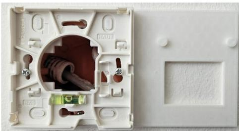
Bringen Sie die Montageplatte an der Position an, wo in Zukunft auch der Router des Wunschprovider stehen wird. Die Montageplatte kann auch mit einem doppelseitigen Klebeband befestigt werden.
