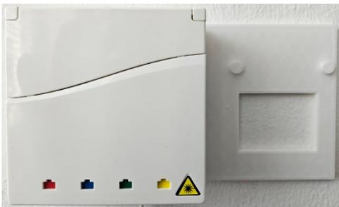
Ist die Montageplatte inkl. der Rückseite der FTU fix montiert, klicken Sie die FTU auf die installierte Rückseite – FERTIG 😊
